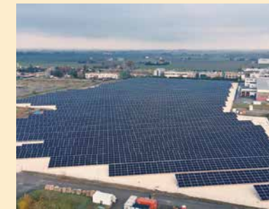
INDUSTRIA E GRANDI AZIENDE 10 MWp - 1 MWp
