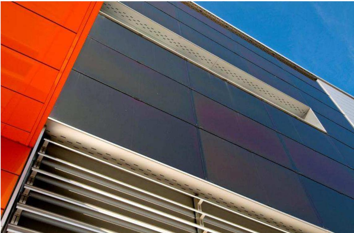
Fig. 10 – Impianti: Facciata Fotovoltaica Ventilata Blacksun.
