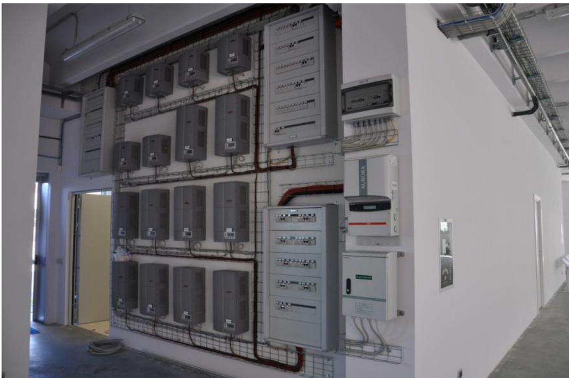
Fig. 13 – Impianti: Inverter Fotovoltaico e Micro Eolico.
