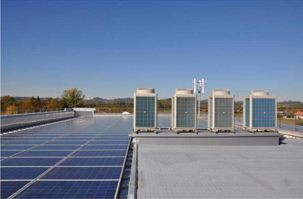
Fig. 11 – Impianti: Fotovoltaico su Tetto e Unità Esterne Pompe di Calore.
